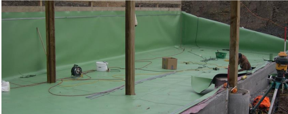
Abb. 13: KD-Anlage Emmen Hüslensmoos: Verschweissen der Abdichtungsfolie. In der Mitte Stützen der Trennwand (vgl. Titelbild). Aufnahme 28.1.2011.
