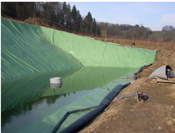
Abb. 14: Wpl Reppischtal, MZA 31: Dichtigkeitsprüfung der Abdichtungsfolie durch Befüllung mit Wasser. Aufnahme 4.2.2011.
