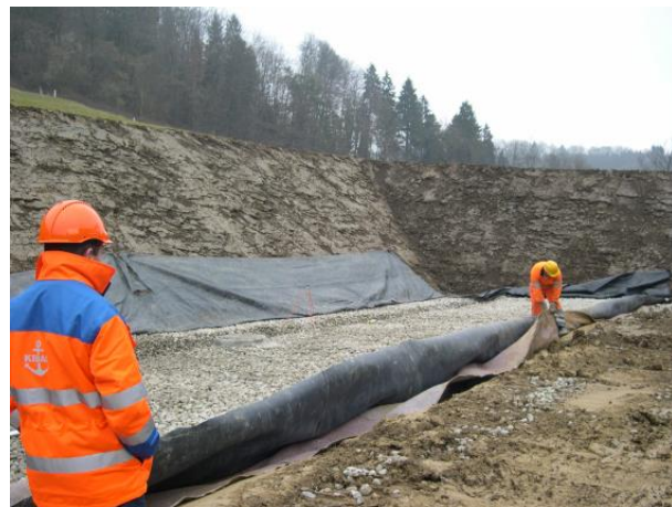
Abb. 15: Wpl Reppischtal, MZA 31: Über der Abdichtung eingebauter Wasserspeicher aus Sickergewöll, hangseitig eingebautes (belastetes) Kugelfangmaterial. Aufnahme 16.2.2011.
