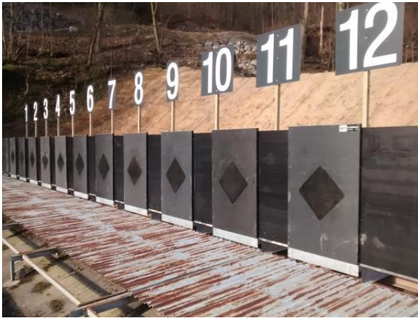
Abb. 3: 300m Schiessanlage Fennen, Niederurnern GL. Emissionsfreie Kugelfangkästen, Ansicht von vorn. Aufnahme 7.3.2016.
