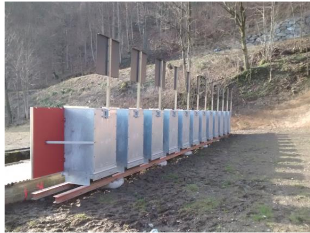
Abb. 4: 300m Schiessanlage Fennen, Niederurnern GL. Emissionsfreie Kugelfangkästen, Ansicht von hinten. Aufnahme 7.3.2016.
